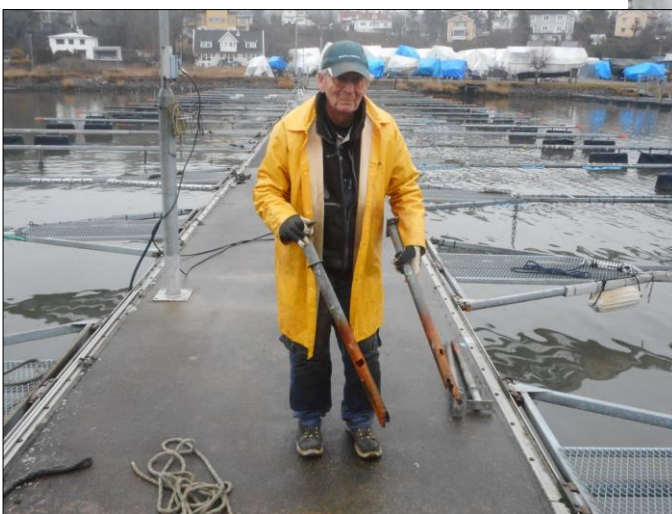
Många flytkroppsrör var nästan bara rost!
